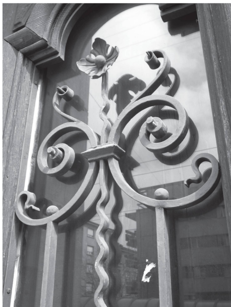
4 Avenue d'Echallens 8. Enroulements en C adossés, terminés par un noyau en corne de bélier et un coup de fouet, assemblés par un collier, 1898 (Photo W. De Marco).
