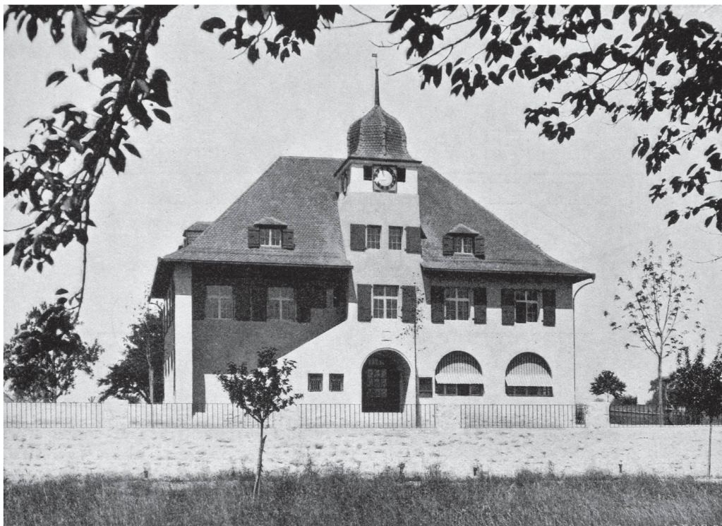
7 Collège de Mies, arch. Maurice Braillard (BAUDIN 1907, p. 401).
