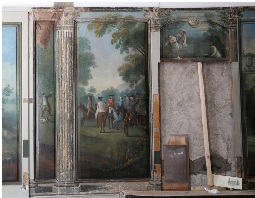
9 Chasse à courre, pendant la mise au jour des cadres, mai 2012 (Photo Atelier Saint-Dismas). On remarque au centre, sous la couche grise (état avant travaux), la peinture faux bois venue masquer le décor peint. On notera la mise au jour des chapiteaux et du paysage qui se poursuit sur le cadre supérieur, ainsi que les socles des colonnes, dont l'ombre portée respecte la lumière provenant des fenêtres.
