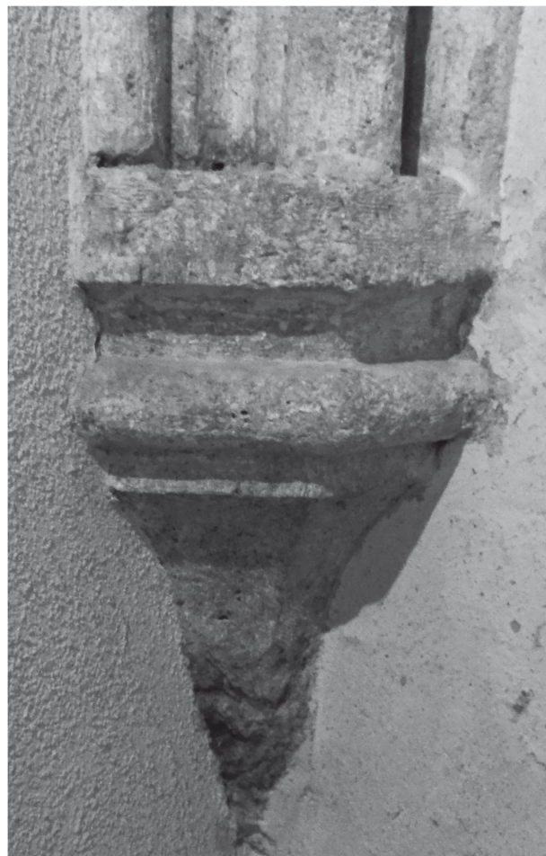
3 Culot d'angle de la voûte (Photo G. Cassina).
