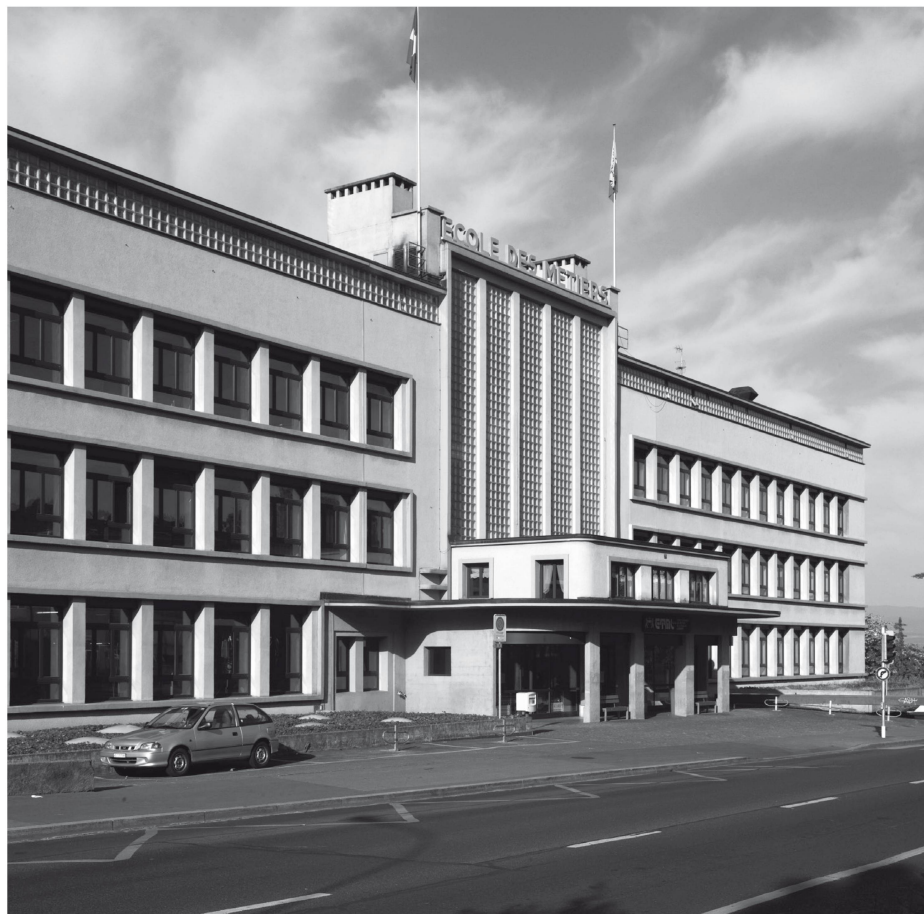
9 Lausanne, Ecole des métiers, façade principale sur la route de Genève (Photo David Quattrocchi).
