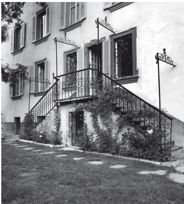
6 Perron ouest (Photo Jean-Marc Biner).
