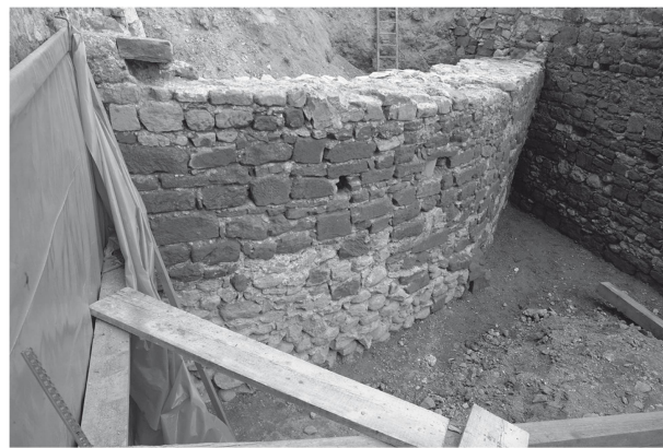
5 Vue de la fouille de la terrasse côté lac avec la tour-bastion de Lesdiguières reposant sur les vestiges de la tour médiévale qui bute contre la façade du corps de logis à gauche (Olivier Feibl – Archéotech SA).
