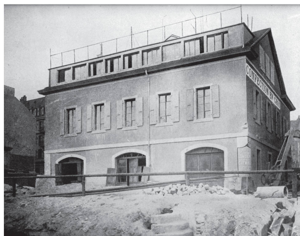
2 A l'angle de la rue des Terreaux et de la rue Mauborget, l'ancien oratoire de Mauborget en 1899, après la démolition du café de Bel-Air et juste avant sa propre démolition (© MHL, photo Edmond Bornand).
