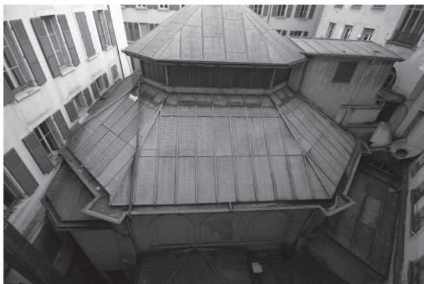
11 Bien que désaffecté, le lanterneau du Kursaal est aujourd'hui toujours en place. En bas, les arcs des baies bouchés postérieurement à la construction (photo Mathias Glaus, 2013).
