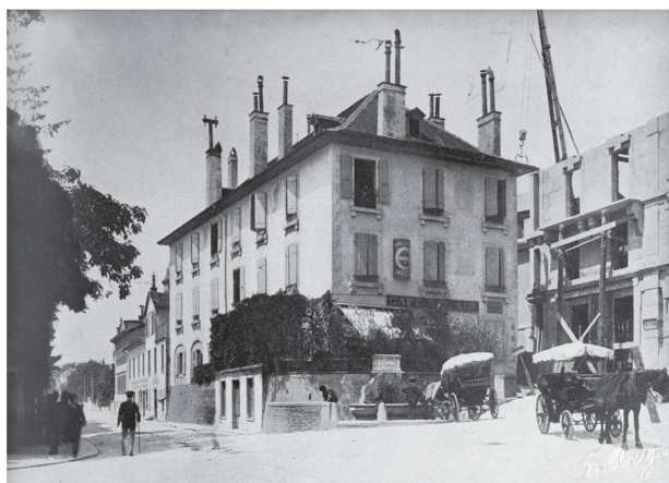
5 Le café de Bel-Air, entre la rue des Terreaux et la rue Bel-Air, en 1898. A droite, l'immeuble place Bel-Air 4 de l'architecte Jacques Regamey en cours de construction (© MHL, photo Edmond Bornand).
