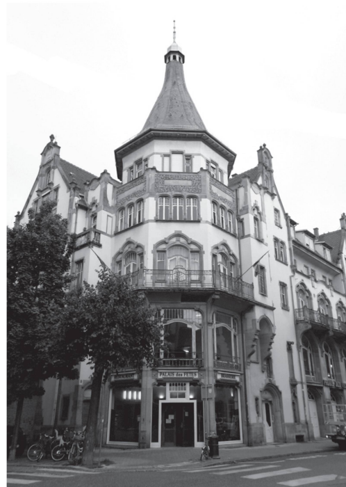
7 Strasbourg, 5 rue Sellénick, ancienne Sängerhaus construite pour le Strassburger Männergesangverein, Kuder & Müller, 1899-1903 (photo Dave Lüthi, 2011).
