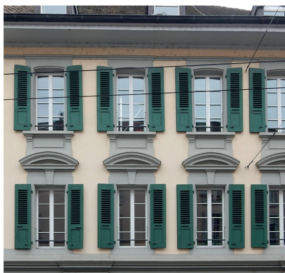
14 Détail de la façade nord, état actuel, avec les encadrements de fenêtres modifiés en 1900 (photo Paul Bissegger, 2015).
