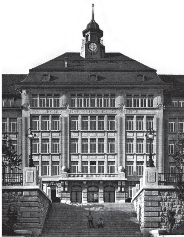
3 Façade sud, détail de l'avant-corps (BTSR 41, 1915, 24, pl. 13).
