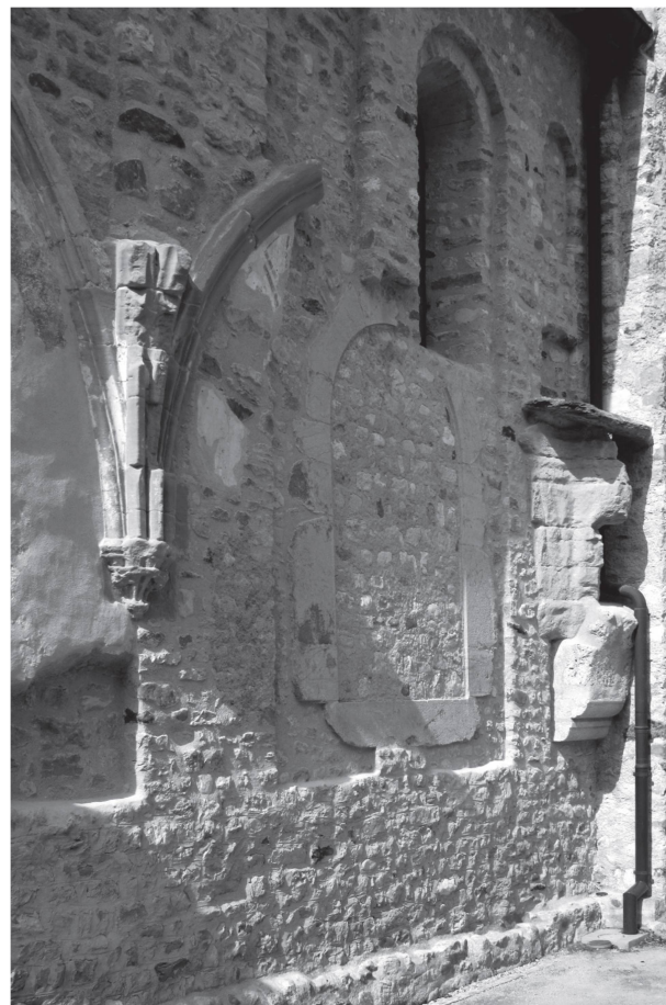
1 Romainmôtier, église abbatiale, vestiges des voûtes du cloître sur la façade sud et divers percements remis en valeur lors de la restauration de 1899-1915 (photo D. Lüthi, 2010).
