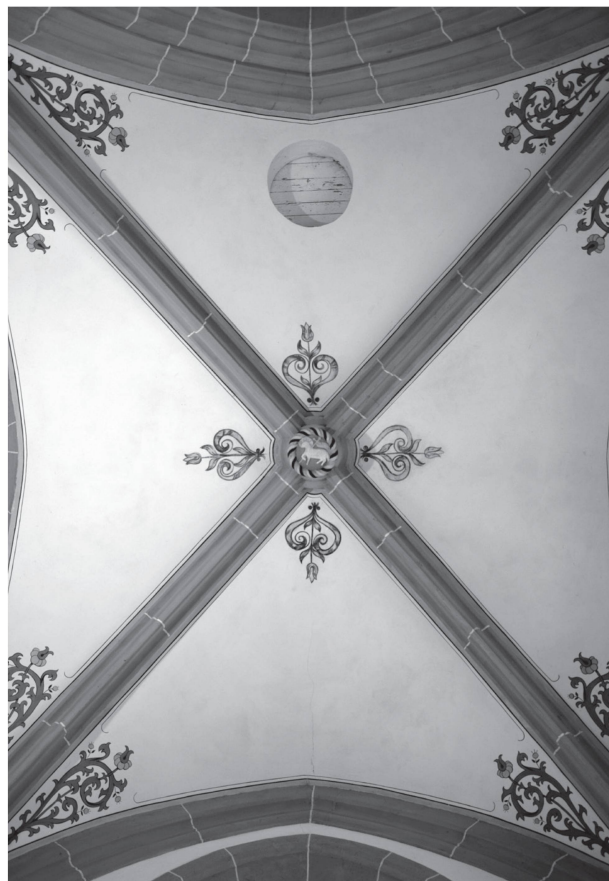
8 La voûte du chœur de l'église de Treytorrens (photo G. Brodard, 2016).
