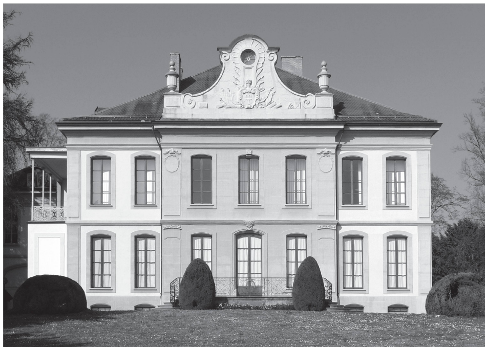
1 L'Élysée, façade sud, état actuel. Le fronton est sculpté aux armes des Fontaines de Cramayel en 1930; à gauche, l'annexe construite pour William Haldimand vers 1846 (photo A.-G. Neipp).
