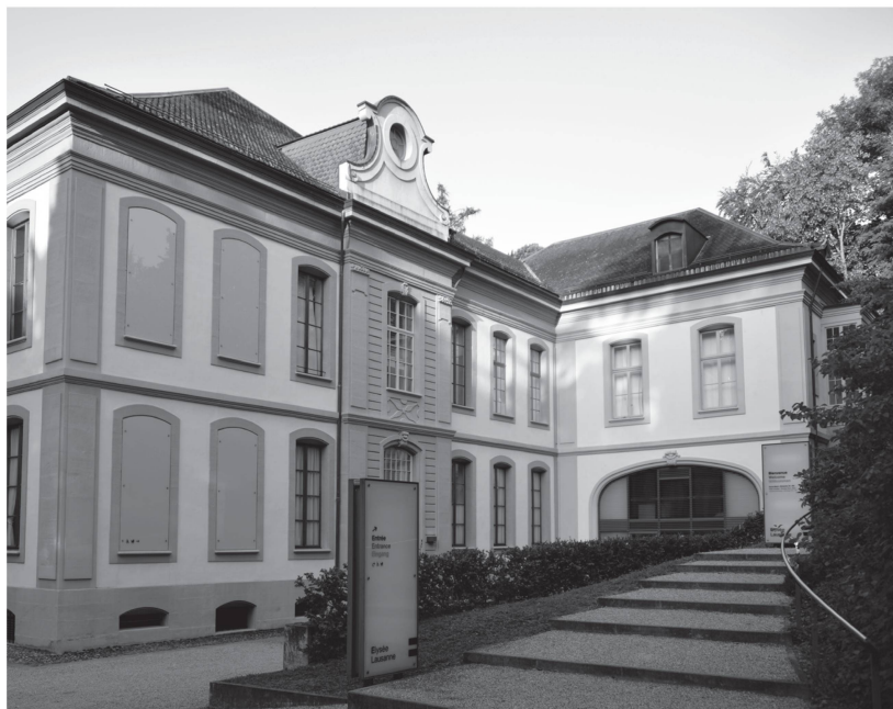
4 L'Élysée, façade nord, état actuel. À droite, l'annexe construite vers 1917 pour Oscar Dollfus (photo Fabienne Hoffmann).
