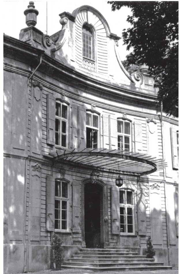
7 L'Élysée, façade est, état avant restauration. La marquise de l'entrée (vers 1917-1924) sera supprimée lors de l'intervention de 1974-1980 (ACV, PP 546/1092 A).
