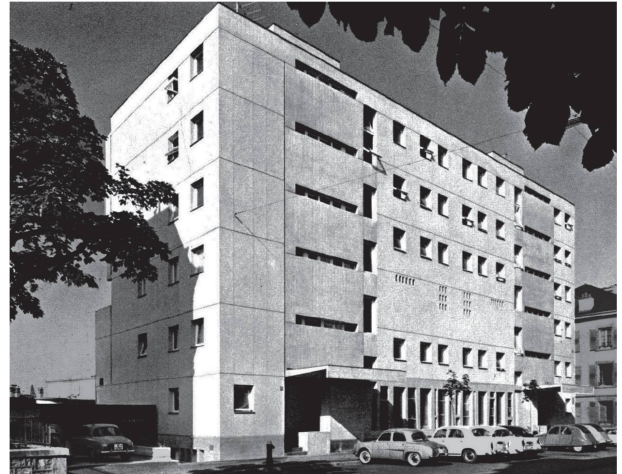
1 Lausanne, Centre universitaire catholique, boulevard de Grancy 29-31, façades nord et est (Habitation 38, 1966, p. 693).
