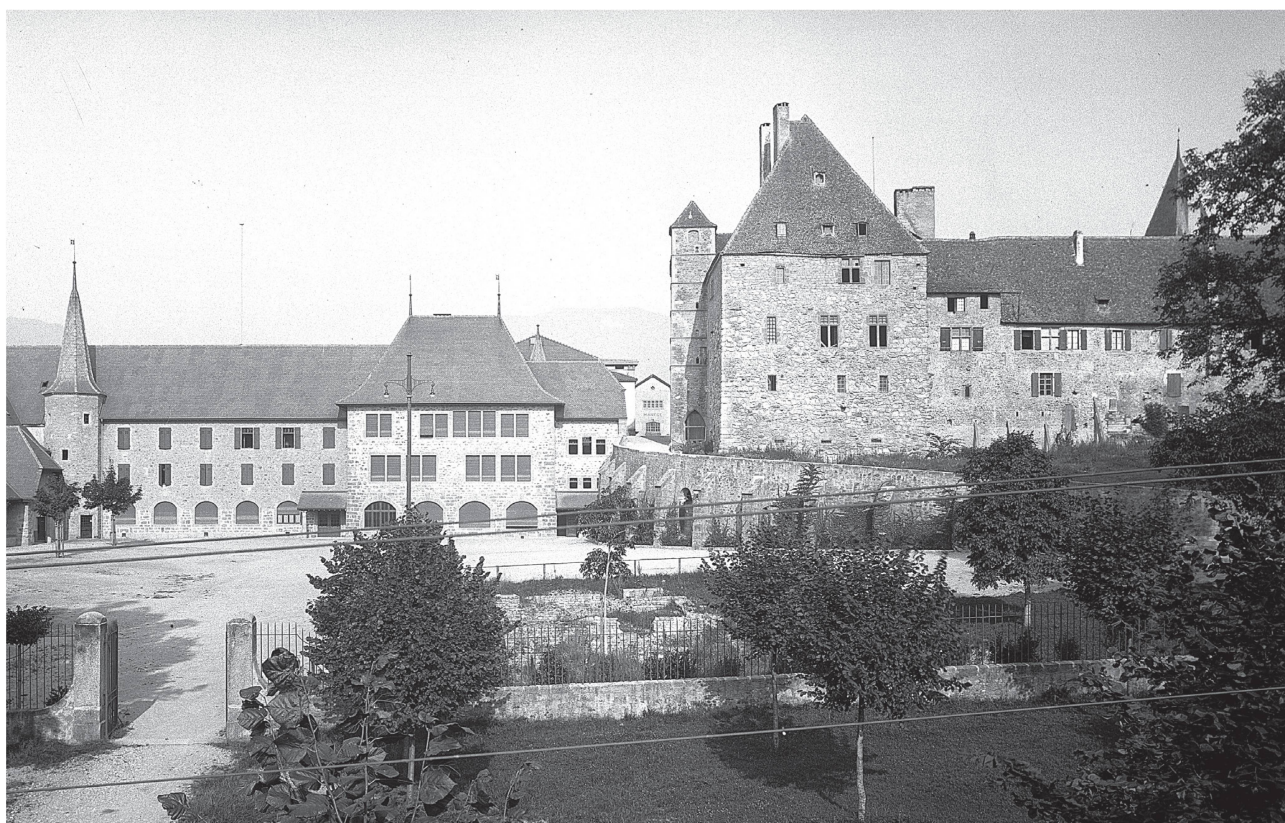
4 En 1910, Matthey s'interroge sur le parti architectural à adopter pour intégrer la future caserne des officiers avec le « vieux château ». Les experts consultés refusent le pastiche médiéval au profit d'un style « moderne » en dialogue avec l'ancien 40 . Achevé en 1914, l'édifice met en œuvre ces recommandations ; en témoignent les toitures, les tourelles, les encadrements et le large usage de calcaire jaune (OPAN, fonds ISCP, 1916).
