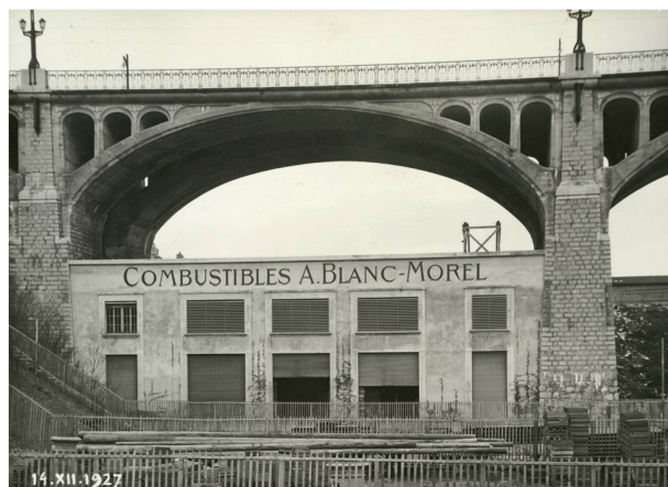
6 Le bâtiment construit par Charles Zbinden sous une arche du Pont Chauderon préfigure ce qu'aurait pu devenir Sévelin si son projet avait été réalisé. Photographie André Kern, 1927 (coll. du MHL).
