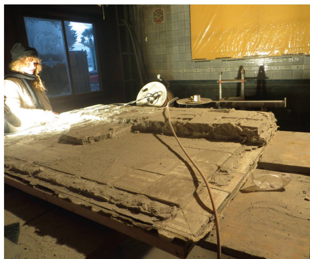
8 Le panneau « Pont sur la Veraye », prélevé, en cours de dégagement du matériel brique/mortier. Sur le mur à l'arrière-plan: le panneau « Temple de Montreux » après encollage des faïences, et pose d'un système de protection sur toute la surface (AM).
