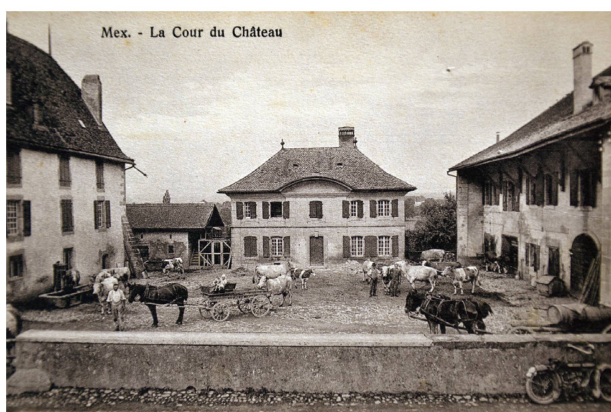
14 Château d'en bas, photographie ancienne de la cour avec les deux dépendances élevées vers 1780. Au fond, la maison dite du four avec une façade en pierre de taille dotée d'un léger avant-corps sommé d'un fronton cintré (Mex, collection particulière).
