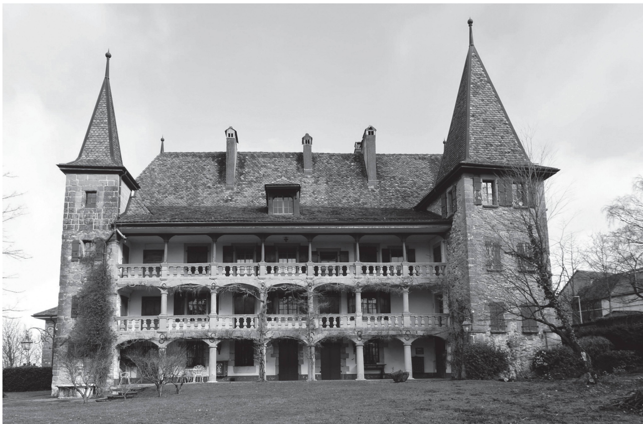
7 Château d'en bas, façade sud avec les galeries et les deux tours élevées en 1652 (Photo Isabelle Roland, 2016).
