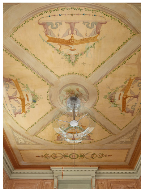
31 Salle à manger du premier étage, plafond peint, artiste inconnu, après 1896 ? (photo Jeremy Bierer)
