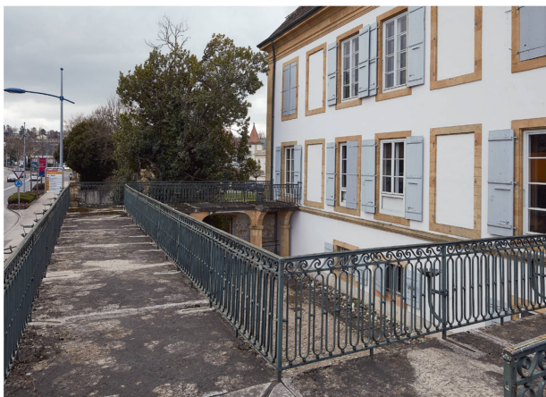
18 La terrasse sur corps de portique, vue générale (photo Jeremy Bierer).
