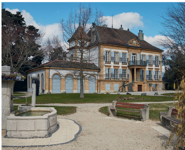
1 Ancienne maison Treytorrens, puis villa d'Entremonts, vue générale du site. Au premier plan, la fontaine de 1778, commandée par les Treytorrens au début de la grande reconstruction de leur domaine des Bains (photo Jeremy Bierer).
