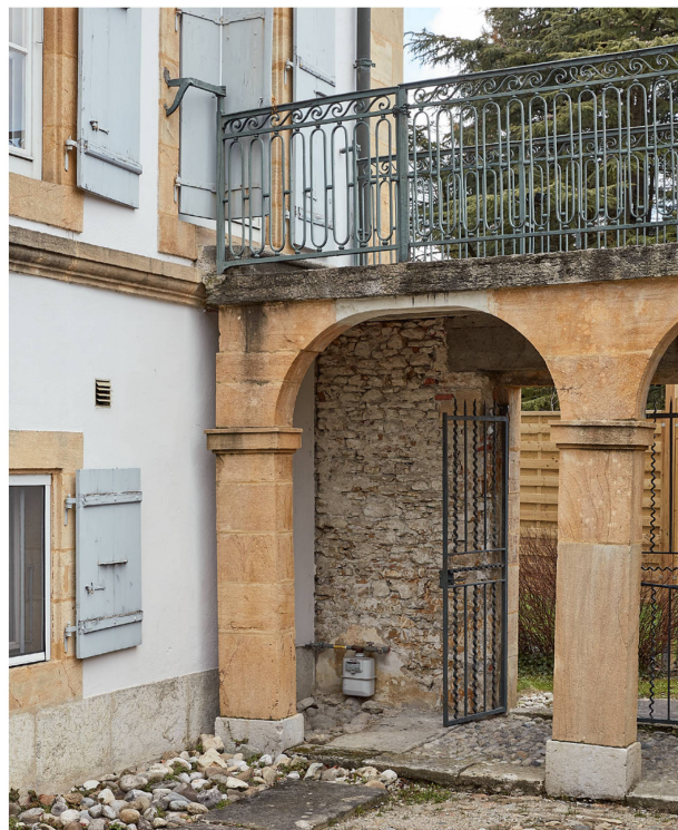
19 Terrasse sur corps de portique, détail montrant la jonction malhabile avec la maison de maître (photo Jeremy Bierer).
