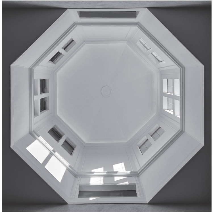
14 La lanterne octogonale après restauration (2011); noter les fenêtres à croisillons du tambour, le décor de corniches et pilastres d'angles intérieurs et la coupole nervurée (photo Rémy Gindroz).
