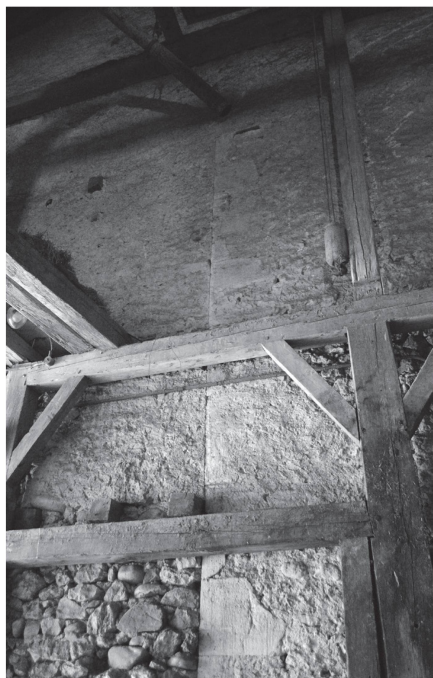
12 Orbe, Montchoisi, chaîne d'angle située à l'ouest de la cage d'escalier (photo Luigi Napi, 2013).
