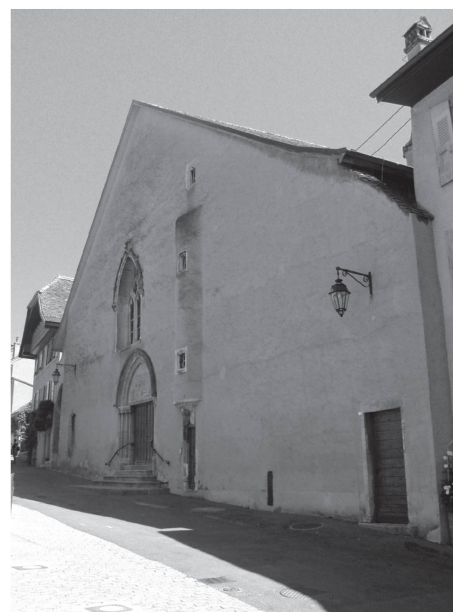
5 Vue de la façade, état actuel (photo L. Proserpi, 2019).
