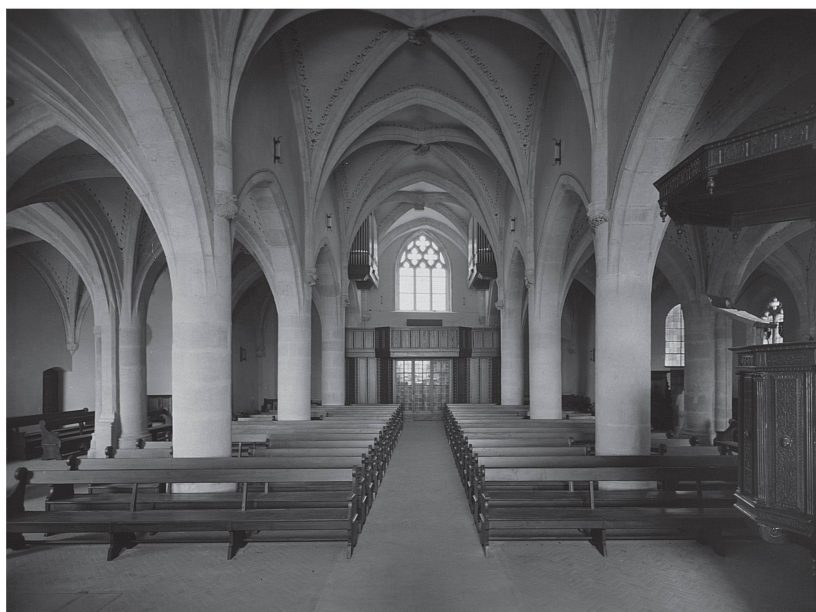
4 Vue de la nef après restauration (ACV, AMH, photo Hippolyte Chappuis)
