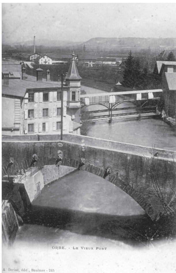
5 Moulins et pont, vers 1902 (Moulin Rod-Patrimoine au fil de l'eau).
