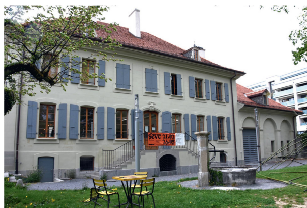
13 Façade orientale, côté cour, état après restauration (photo Ville de Renens, 2017).
