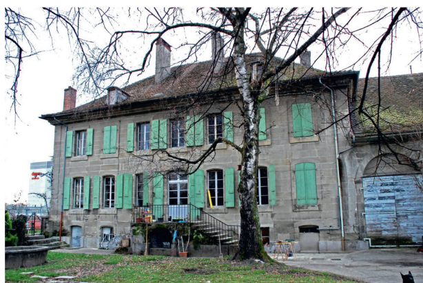
12 Façade orientale, côté cour, état avant restauration (photo Isabelle Roland, 2013).
