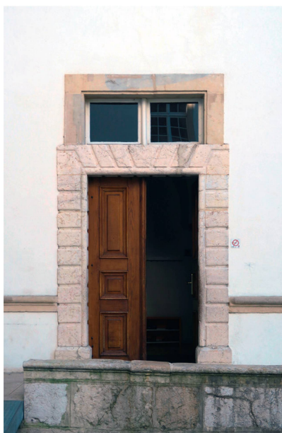
5 Delémont, château, portail d'entrée ouest (photo Adrien Noirjean, 2019).
