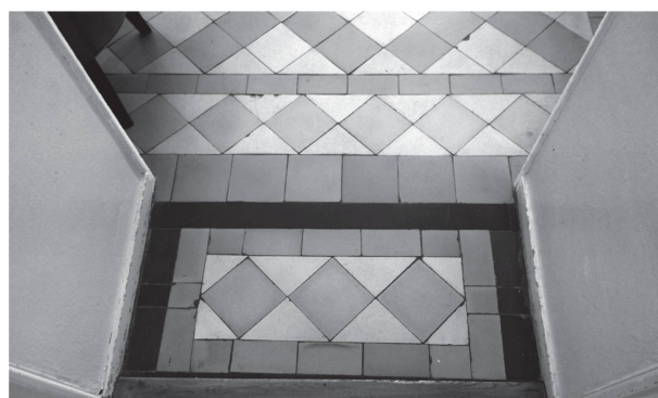
7 Sol d'un appartement avec carreaux de ciment colorés (photo Catherine Schmutz Nicod, 2018).
