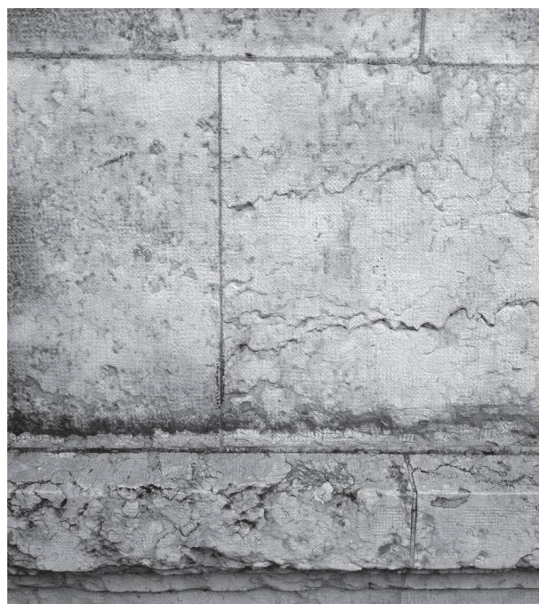
6 Façade nord de l'immeuble, détail montrant la mise en œuvre de la pierre de Villebois (photo Catherine Schmutz Nicod, 2018).
