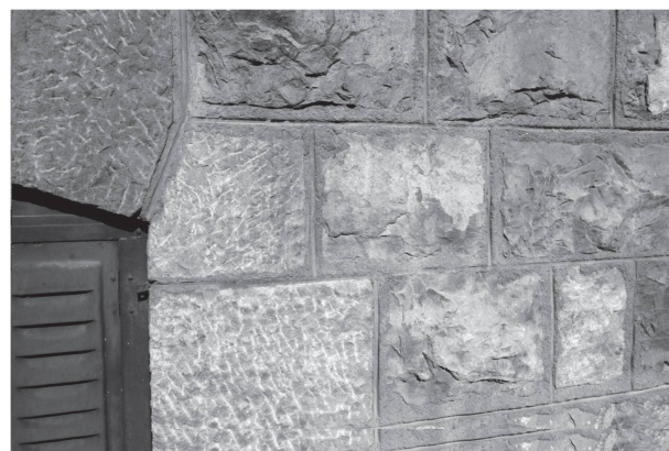
4 Façade sud, détail montrant la mise en œuvre de la pierre de Meillerie (photo Catherine Schmutz Nicod, 2018).
