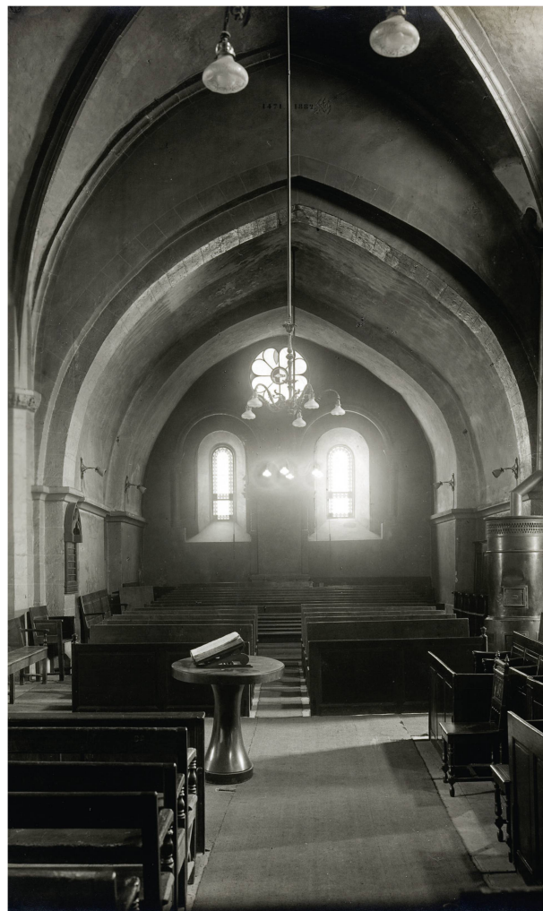
5 Vue vers le chœur. État avant la restauration de 1925-1926 (AFMH, EAD-54437).
