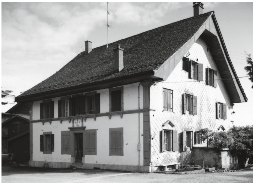
5 En Pra Charbon près de Savigny, la grande « carrée » de 1834, vue de l'ouest (ACV, photo Claudine Glauser).
