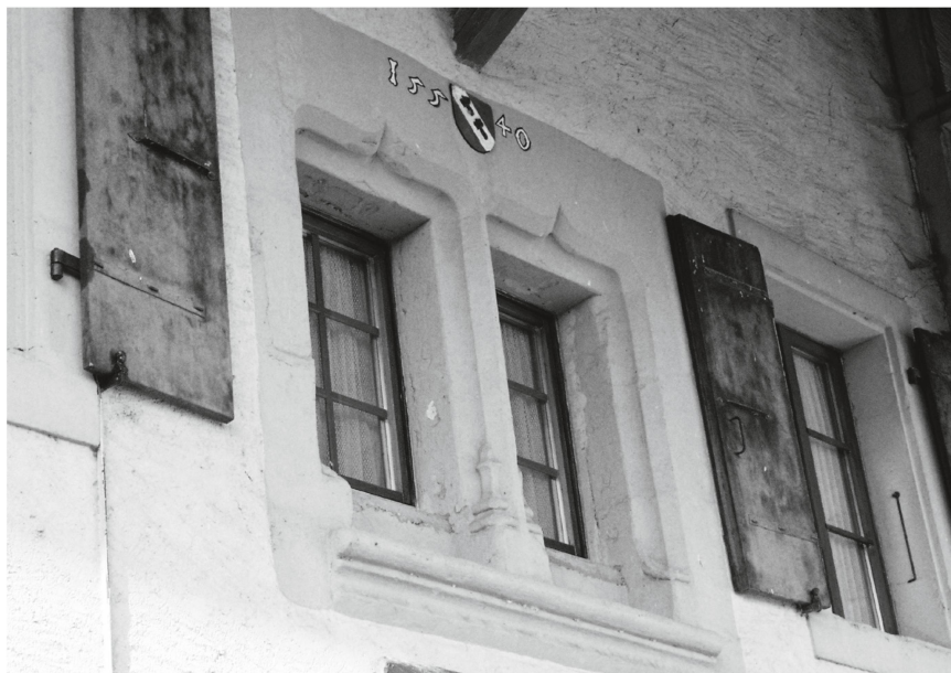
1 La Maillardoule, commune de Forel. En 1554, le blason de la famille Maillardoz sur la ferme du domaine agricole complétant les vignes de Grandvaux (photo Denyse Raymond).
