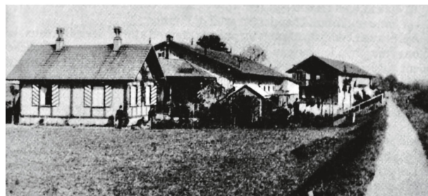
3 Les premiers bâtiments, provisoires, de la Colonie de l'Orbe (1877-1896), aujourd'hui démolis (ANSELMIER, 1993, p. 108, photographie tirée de Informations pénitentiaires suisses, 1955).
