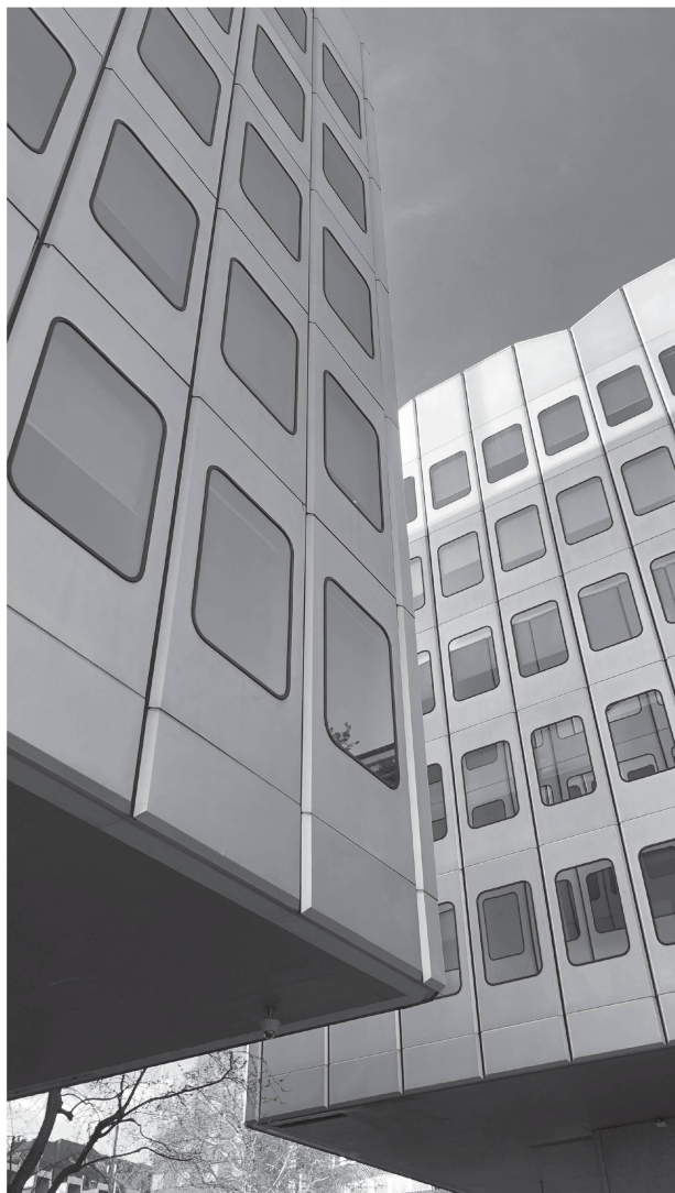
6 Détail des façades des corps d'étages des bâtiments sud et est (photo Diego Maddalena).
