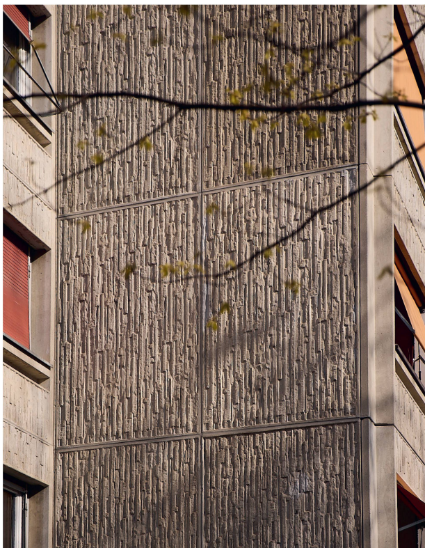
5 Détail d'une façade pignon (photo Jeremy Bierer, 2021).
