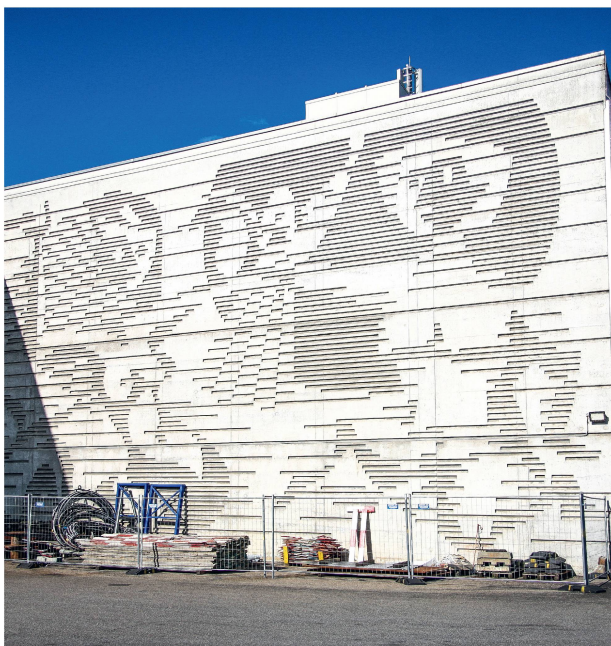
6 Jean-Pierre Desarzens, station d'épuration de Lausanne à Vidy, fosse des boues, façade sud, 1966-1968 (photo Manon Samuel, 2019).
