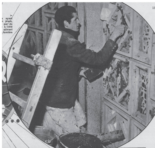
8 Un ouvrier procédant au cimentage des panneaux de dalle de verre de la chapelle de l'Université de Fribourg, 1942 (L'Écho illustré 23, 6 juin 1942, p. 12).
