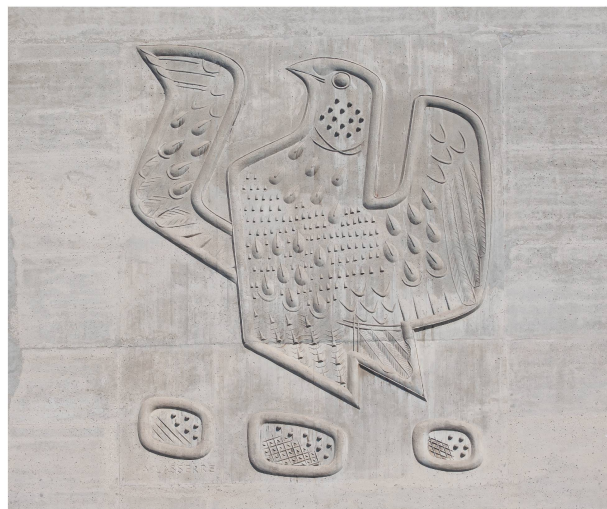
1 André Lasserre, Oiseau , 1953, béton franc de coffrage, 6 x 4,5 m, Collège du Belvédère, Lausanne. Coffrage en bois assemblé, relief taillé à la main, coulé avec le mur en béton franc de coffrage. Architecte Marc Piccard (Collection d'art de la ville de Lausanne, photo Kevin Seisdedos).
