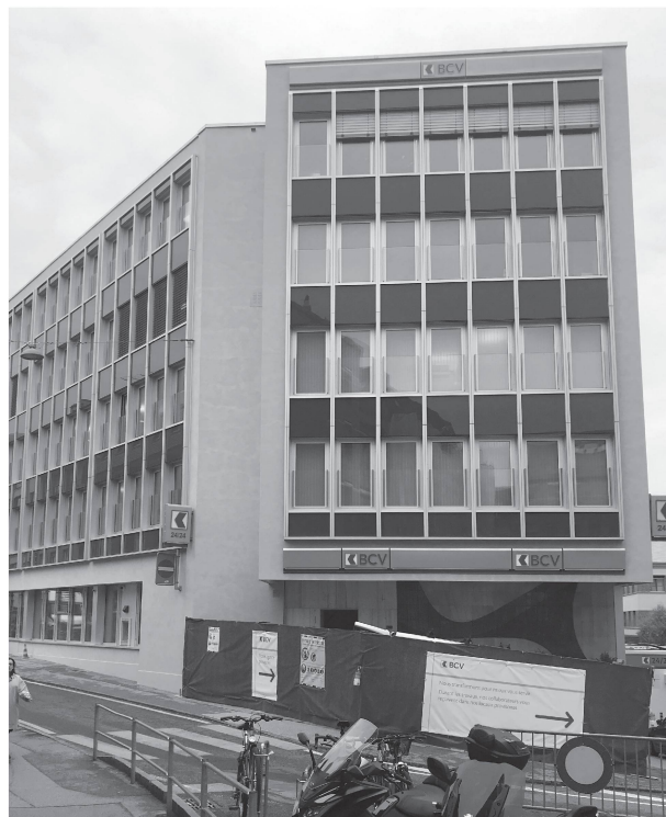
2 Paul Blondel, succursale de la Banque Cantonale Vaudoise à Nyon, achevée en 1969. État après transformation et banalisation des façades (photo Raffaele Amoroso, 2019).
