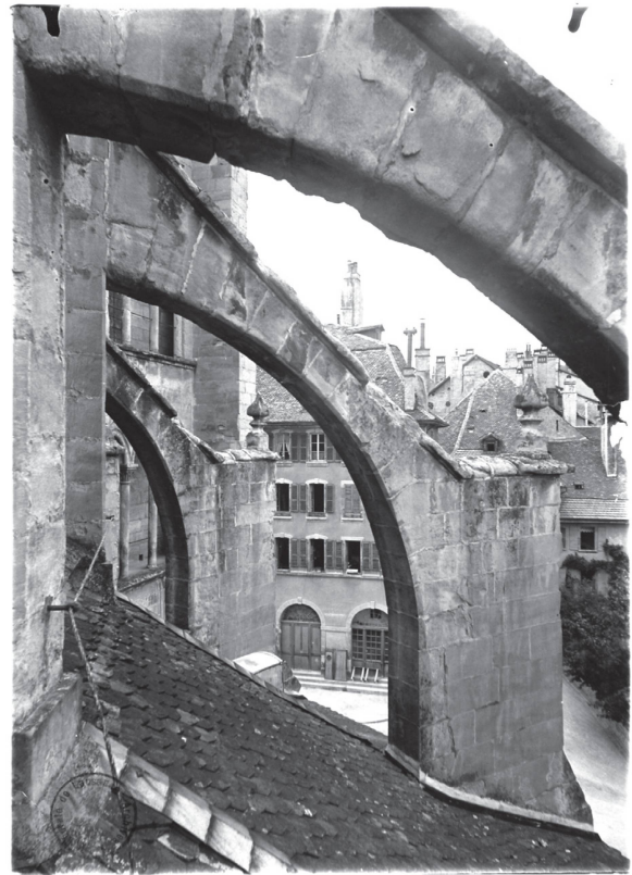
3 Arcs-boutants du chœur reconstruits entre 1768-1774 en molasse de la Barre. État en 1909 (ACV, SB 52 Aa/35/30).
