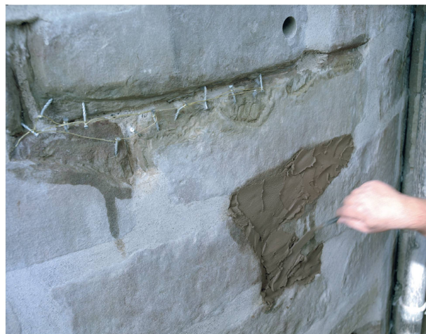
4 Ragréage par application d'un mortier de molasse en 2007 (Documentation photographique de la Ville de Genève, Photo Claudio Merlini).
