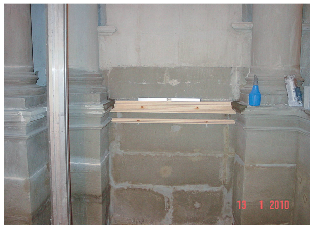
5 Réparation d'une corniche intérieure au moyen de profils en bois avant badigeon en gris molasse à la travée 2 sud (TS2) (© Stanislas Rück, Fribourg).
