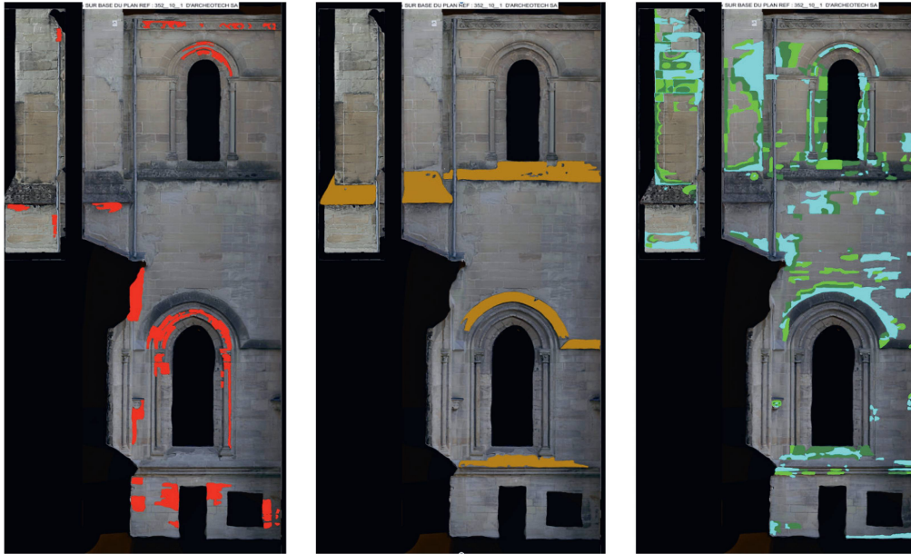
7 Illustration photographique reportant en couleurs les zones suivantes : à gauche : non exposées à la pluie (croûte noire) ; au centre : zone humide (apparence noire due à une activité biologique) ; à droite : altérations liées à l'eau (perte de matière, plaques et décollements). Image reportée sur le relevé d'Archéotech SA (REF 350-10-1).
