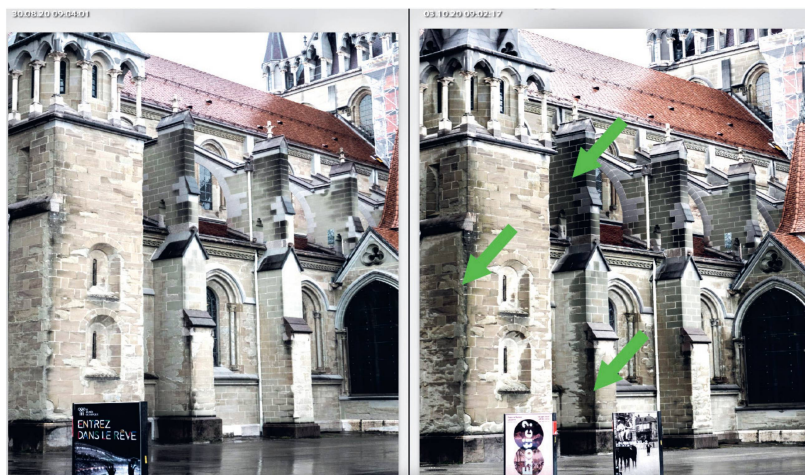
3 À gauche, situation fréquente d'exposition à une pluie verticale avec un faible vent. Les fonds de façade, contreforts et arcs-boutants (à l'exception de leurs culées) ne sont pas touchés. Cette situation permet d'observer l'efficacité des systèmes architecturaux mis en place pour éloigner l'eau des façades. À droite, situation de pluies battantes (vent 8-20 km/h de sud-sud-ouest) mettant en évidence la diversité des zones touchées (flèches vertes), l'importance de l'impact sur les arcs-boutants et entre autres la particularité des plaques demeurées en place qui se mouillent davantage que les dépressions de 2 à 3 cm laissées par la chute d'une plaque.
