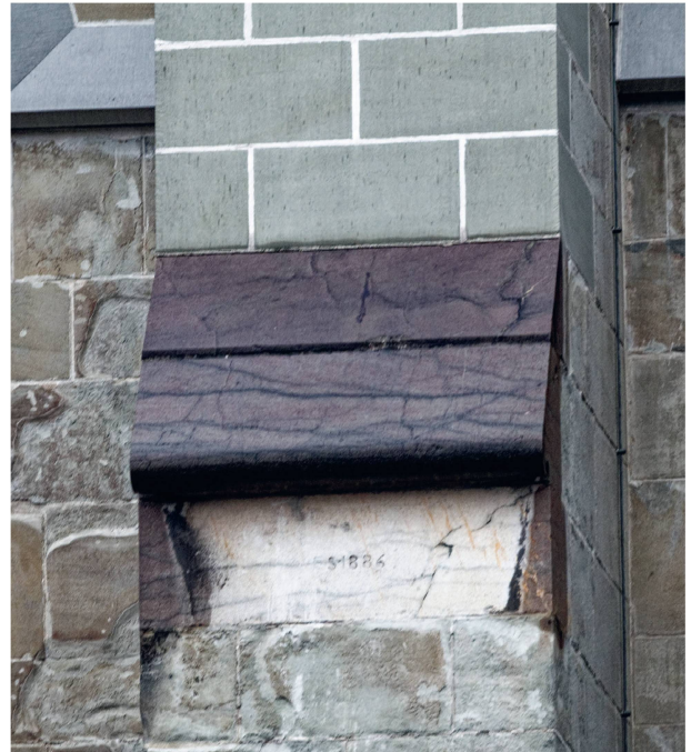
14 Contrefort de bas-côté, retraite à bec, Henri Assinare, 1886, avec débordements latéraux du talus, effet goulot au cavet et, consécutivement, altération angulaire du contrefort inférieur (photo Rino Sàrl, 2019).
