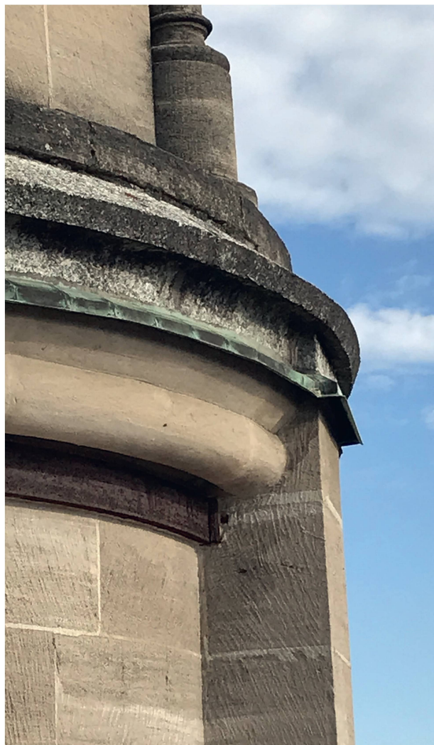
17 Tour du beffroi, stylobate de la tourelle nord-est; insertion d'un coupe-larme en cuivre entre deux assises de la corniche talutée, première moitié du XX e siècle; l'efficacité du larmier de ferblanterie se mesure à la différence de développement micro-organique qu'il y a entre les pierres situées au-dessus de la ferblanterie et celles qui se trouvent au-dessous (photo Amsler Dom arch., 2020).
