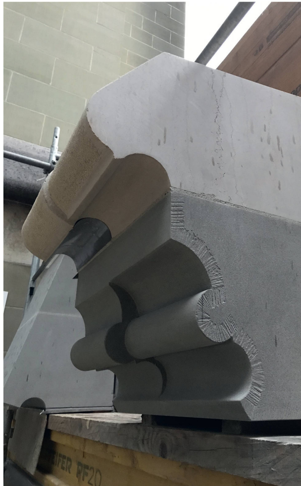
9 Modèle de la corniche de la tour lanterne retaillée (photo Amsler Dom arch., 2020).
