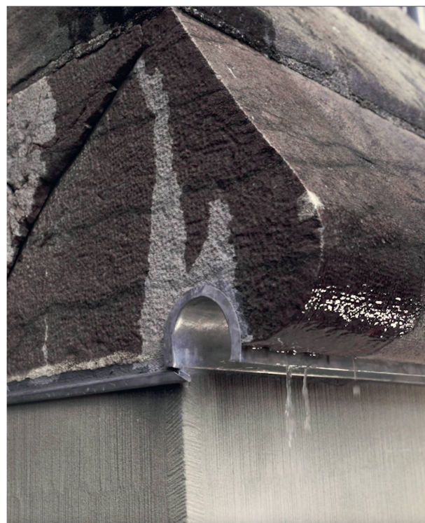
7 Coulisse dans le joint d'assise et sa garniture de cavet en fonctionnement lors d'un essai in situ (photo Jeremy Bierer, 2021).
