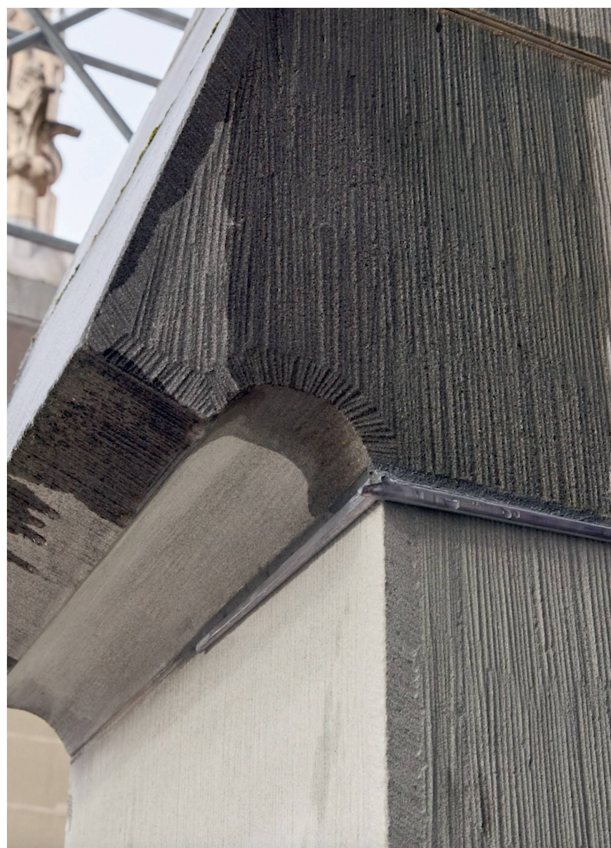
6 Coulisse dans le joint d'assise en fonctionnement lors d'un essai in situ (photo Jeremy Bierer, 2021).
