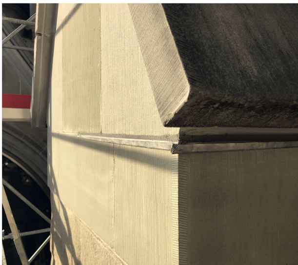
3 Coulisse insérée sur un chaperon de la cathédrale (photo Amsler Dom arch., 2021).
