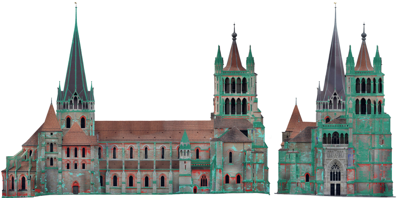
C3 Pathologies des façades nord et ouest : la façade ouest est partiellement atteinte par les colonisations biologiques, à cause de la direction des vents provenant du nord-ouest.
