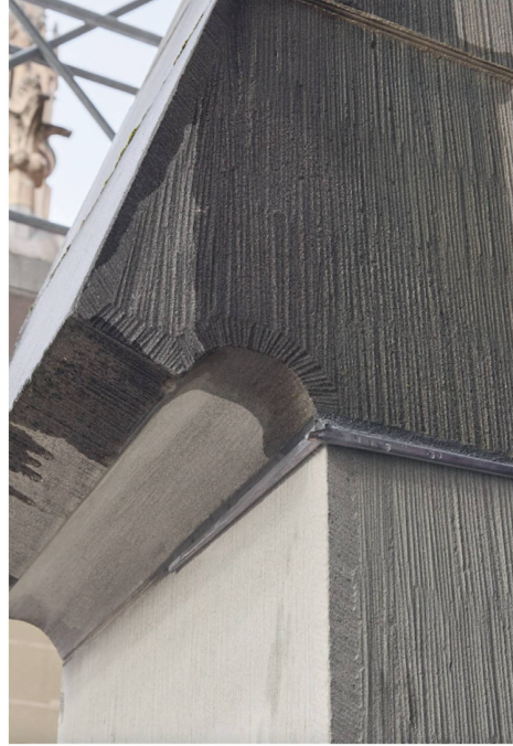
2 Coulisse insérée dans le joint inférieur du larmier.
