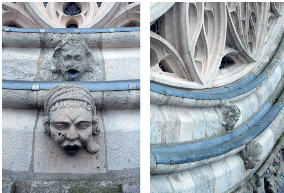
4 Rose de la cathédrale d'Amiens (photo J.-F. Cabestan, 2020). Les roses d'Amiens et de Lausanne présentent des réponses différentes à une difficulté commune : le ruissellement de l'eau sur des moulures toriques. Ces deux exemples montrent que les réflexions menées autour des problèmes de l'eau sont diverses et les solutions qui en résultent multiples.
