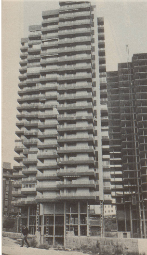
4 Bei diesem zwanzigstöckigen Spekulantenbau, wie sie auch an der Costa Blanca nur so aus dem Boden schiessen, scheinen sich die Architekten über das Parterre noch nicht einig zu sein.
