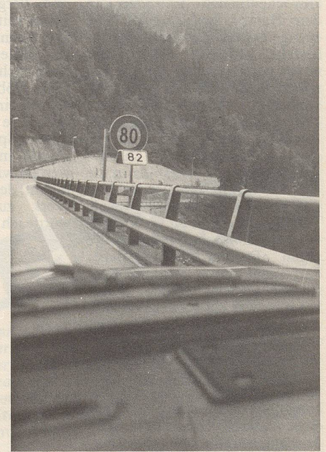
Was gilt auf der Viamala-Brücke über den Hinterrhein: 80 oder 82 km/h?
