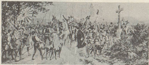
26. August 1444: Drunten in der Birsebene tobt die Schlacht. Eben sind die Basler Hilfstruppen an der Stelle des heutigen St. Jakobs-Denkmal's angekommen. Alle möchten die hart bedrängten Eidgenossen unterstützen. Da wird den Hauptleuten gemeldet, dass grosse Gefahr bestehe, dass die von Verteidigern entblösste Stadt in die Hände weiterer, bei Gundeldingen lauerner Feinde fallen könne. Sie beschliessen schweren Herzens den Rückzug ...
