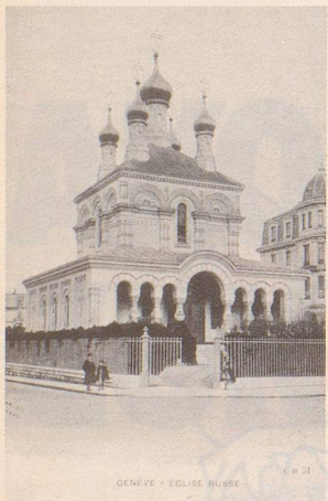
Die russische Kirche in Genf wurde 1866 vom Petersburger Architekten Grimm projektiert und von den Genfer Unternehmern Guillebaud, Kraftt & Broillet als Viereckbau im neobyzantinischen Stil gebaut. Fünf vergoldete Kuppeln krönen diese russisch-orthodoxe Kathedrale aus der Zarenzeit. Gemälde im Kirchenschiff stammen von Louis Rubio. 1916 erfolgte eine Renovation, die auch eine Änderung der Innenausstattung umfasste.
