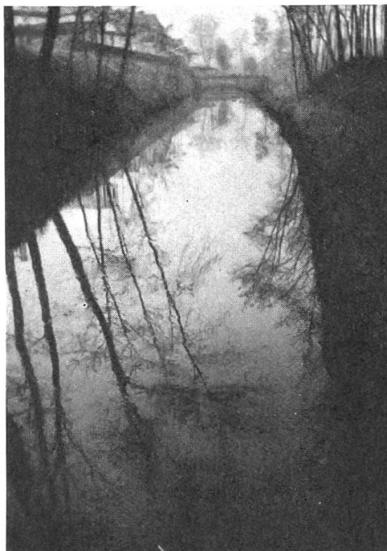
Abbildung 6. Kanal zur untern Fabrik der Florettspinnerei Ringwald in Niederschönthal. Verlangsamung der Fliessgeschwindigkeit im Oberwasserkanal. 29. 12. 32.
