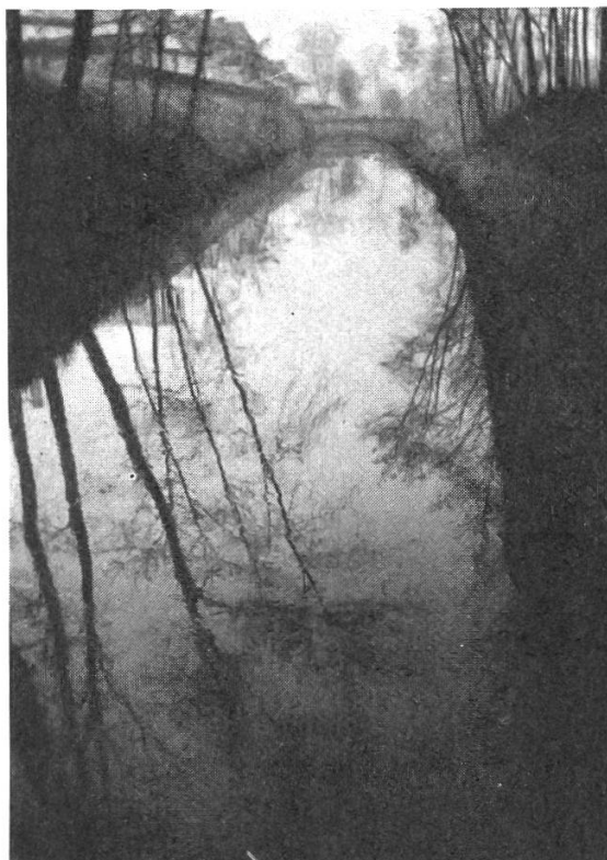
Abbildung 6. Kanal zur untern Fabrik der Florettspinnerei Ringwald in Niederschönthal. Verlangsamung der Fliessgeschwindigkeit im Oberwasserkanal. 29. 12. 32.
