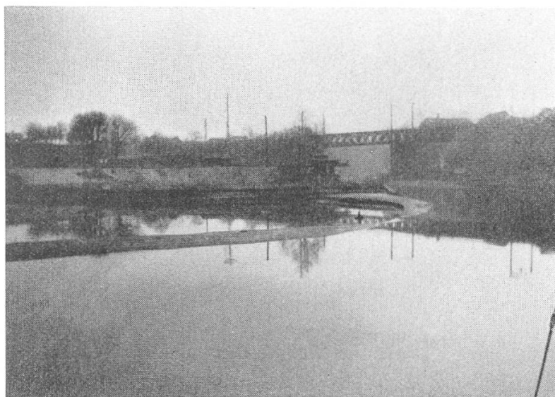
Abbildung 17. Gestauter Endlauf der Ergolz. Sedimentbank von der alten Saline bis zur Kraftwerkbrücke an der rechten Seite des Hauptstromes der Ergolz durch den gestauten Endlauf. Absenkung des Stauspiegels um 1.00 m. 26. 3. 33.
