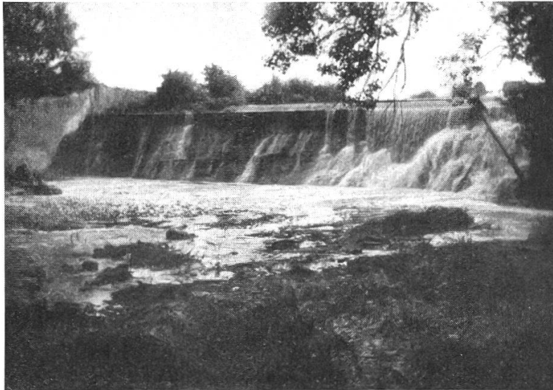
Abbildung 14. Wehrpritsche (Hülftenpritsche) zum Kanal der Aktienmühle in Augst. Starke Zerstäubung des Wassers ermöglicht die Aufnahme von Sauerstoff. Mittlere Abflussmenge 0.9 m 3 /s. 29. 12. 32.
