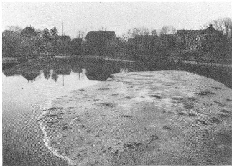
Abbildung 18. Gestauter Endlauf der Ergolz. Sedimentbank oberhalb der Kraftwerkbrücke. Absenkung des Stauspiegels 0.60 m. Beginn der sommerlichen Vegetationsentwicklung auf der Schlammablagerung. 26. 3. 33.
