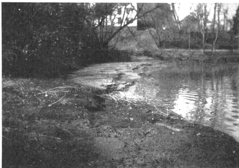
Abbildung 16. Gestauter Endlauf der Ergolz. Faulschlamm-Ablagerungen mit Abbruchlinien infolge Senkung des Stauspiegels um 1.00 m. 26. 3. 33.
